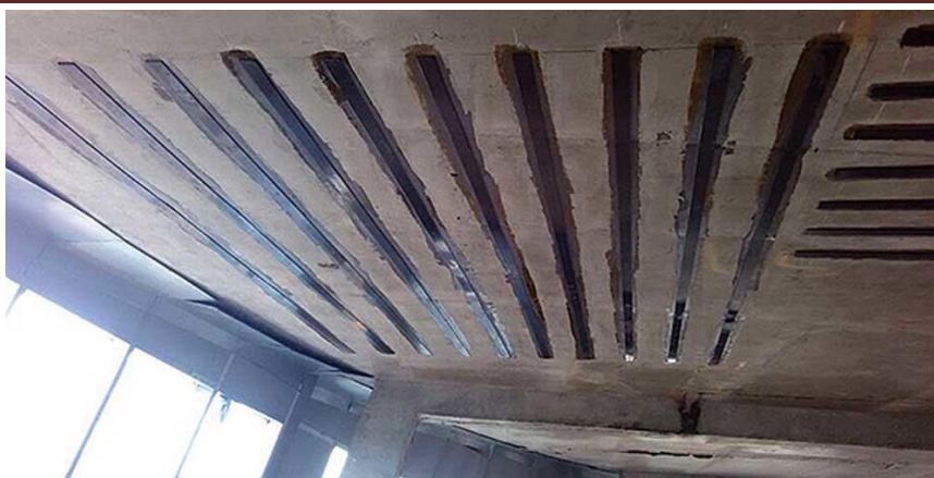
Сурет 3: Темірбетон құрылымының элементін көміртекті пластикалық ламелалармен нығайту
