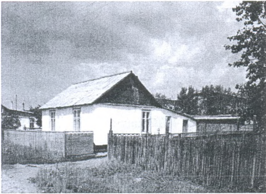
Рисунок 13. Отдельно стоящие, одноэтажные жилые дома. Республика Казахстан, Карагандинская область, Осакаровский район с.Осакаровка
