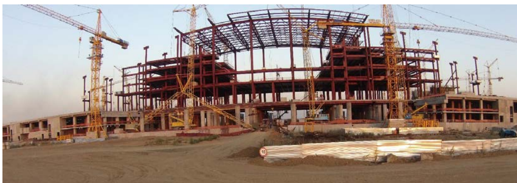
Рисунок 1: Общий вид строящегося объекта
