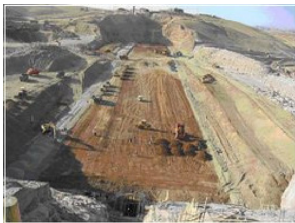
3 сурет: Жер бөгетін тұрғызу кезінде шөгуді бақылау (Mollasadra, Iran)
