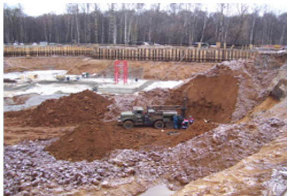
2 сурет: Биік тұрғын үй ғимаратына геотехникалық мониторинг жүйесін орнату (Мәускеу қ., Дыбенко көш.)
