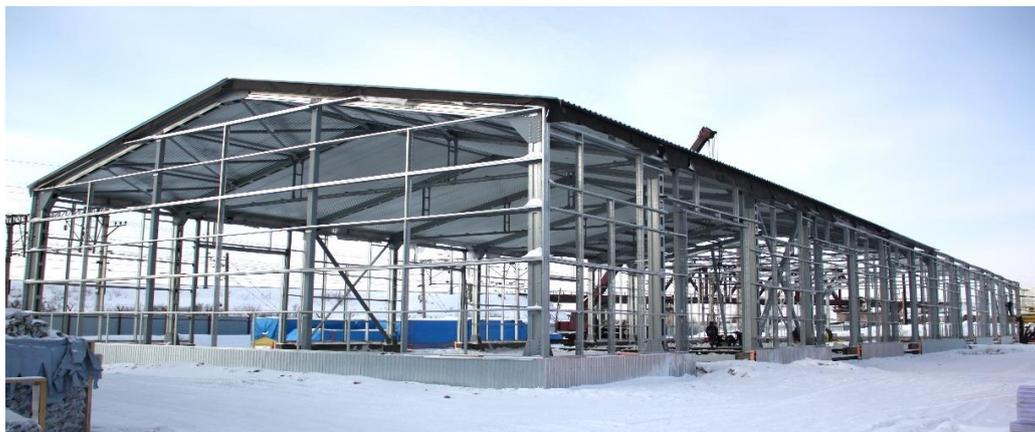
Рисунок 2: Строительство здания из лёгких стальных тонкостенных конструкций
